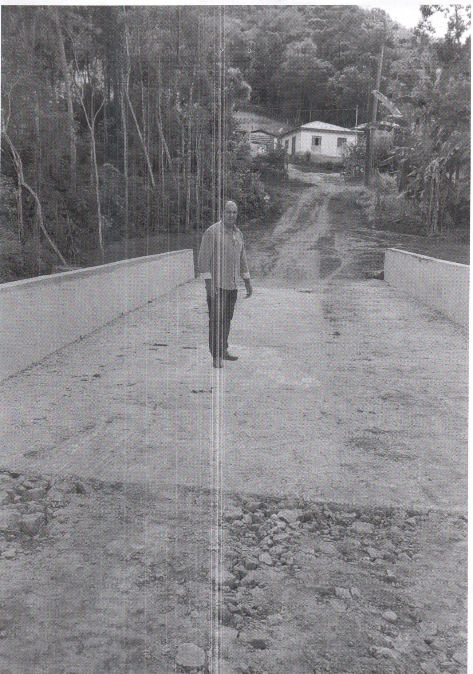
26/04/2024 Ponte do Posto Limão 15KM
