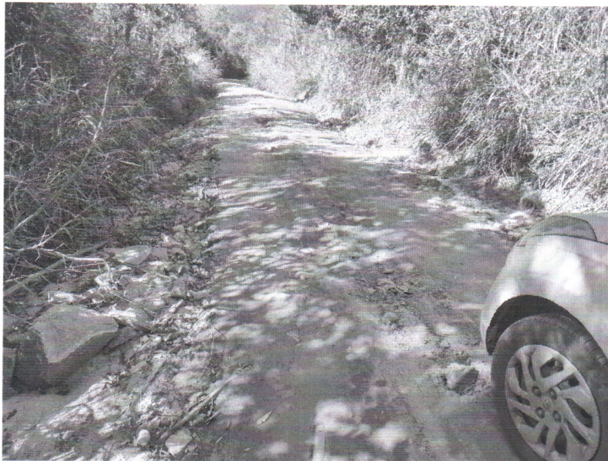
24/05/2024 - Vistoria nas estradas vicinais, atendendo demanda de moradores da região.
