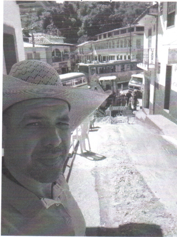
03/05/2024 – Vistoria na obra da Saneouro, no bairro São Cristóvão.
