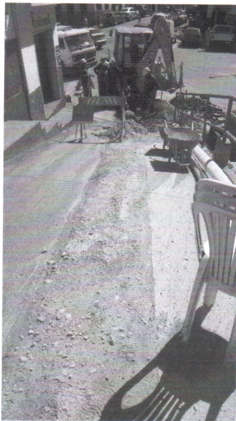
03/05/2024 – Vistoria na obra da Saneouro, no bairro São Cristóvão.
