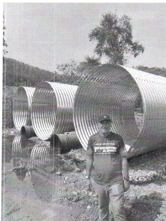
07/09/2024 - Fiscalização de obra em execução no subdistrito Santo Antônio.
