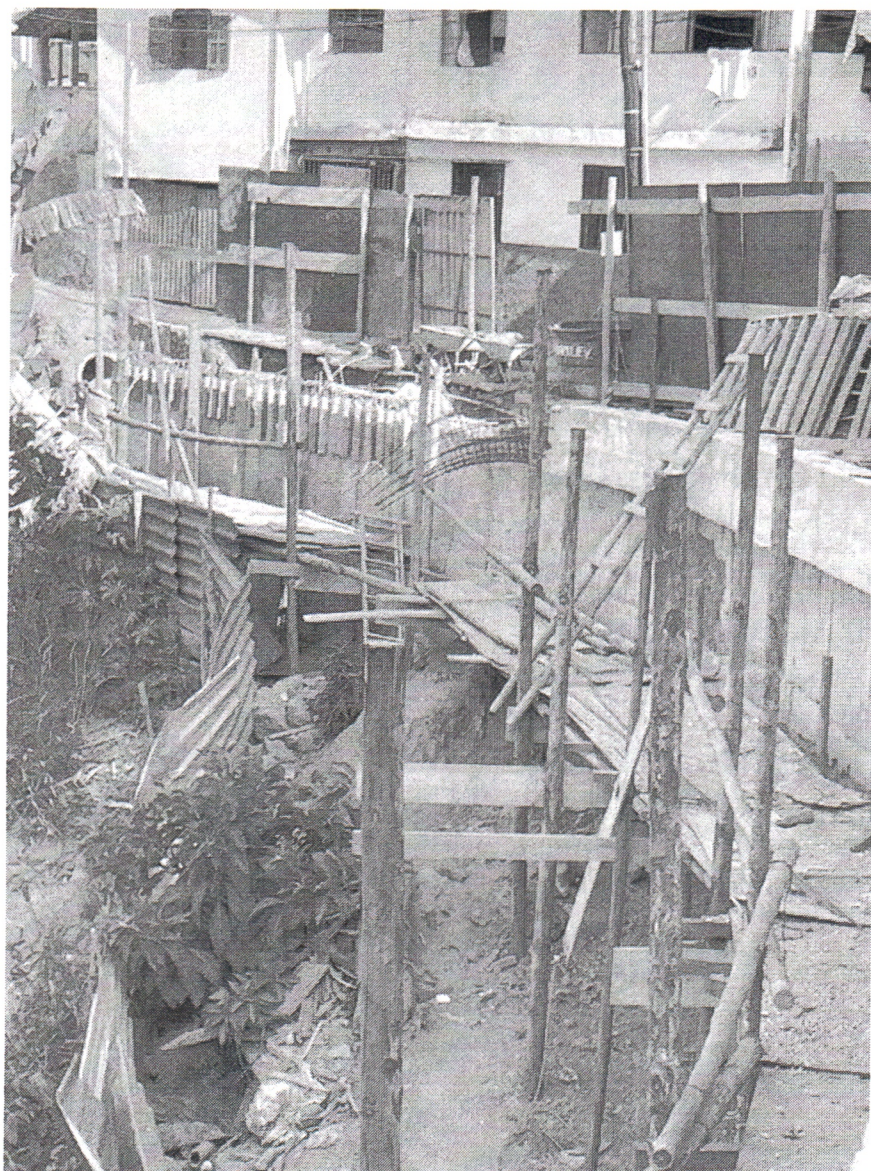
Obra Geraldo Jesus Gonçalves no caminho da fábrica - 09/10
