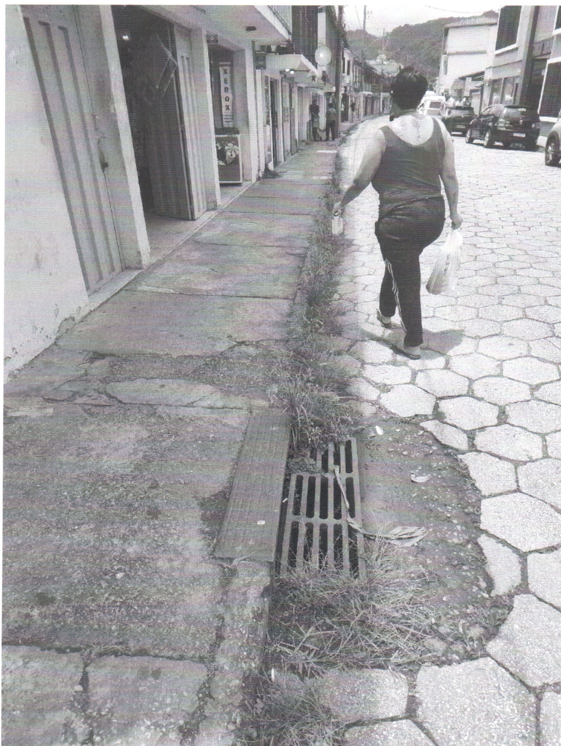
30/10/2024 - Vistoria no bairro Bauxita – Ouro Preto
