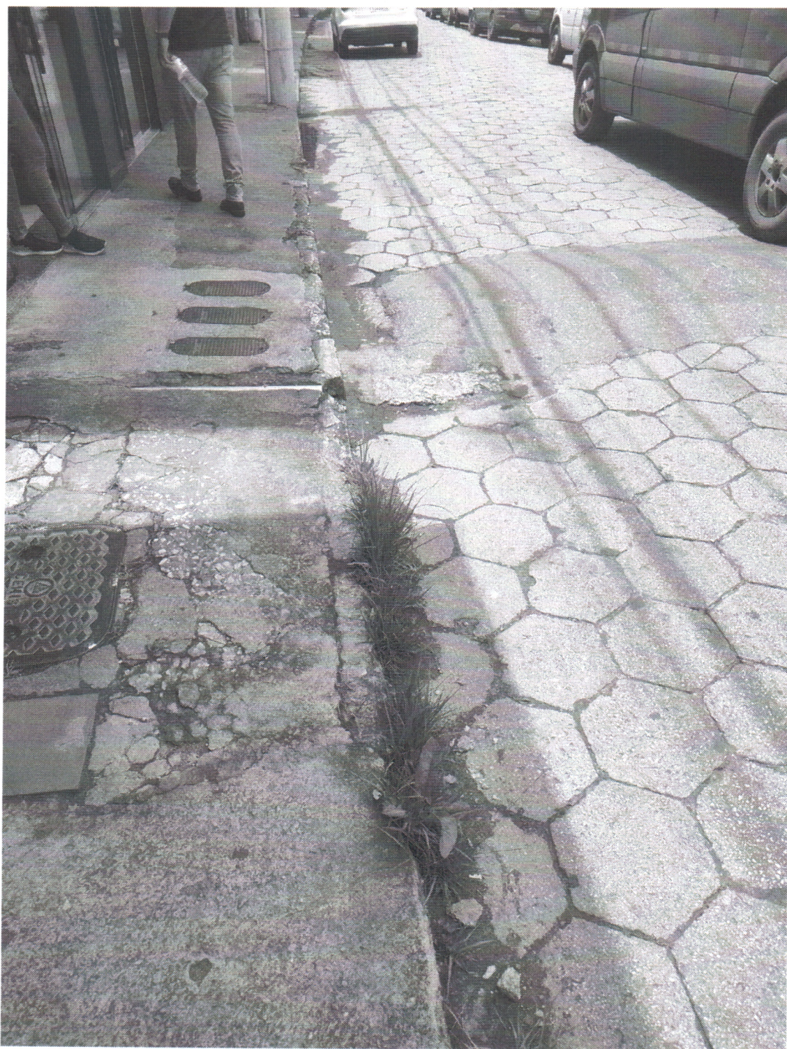
30/10/2024 - Vistoria no bairro Bauxita – Ouro Preto
