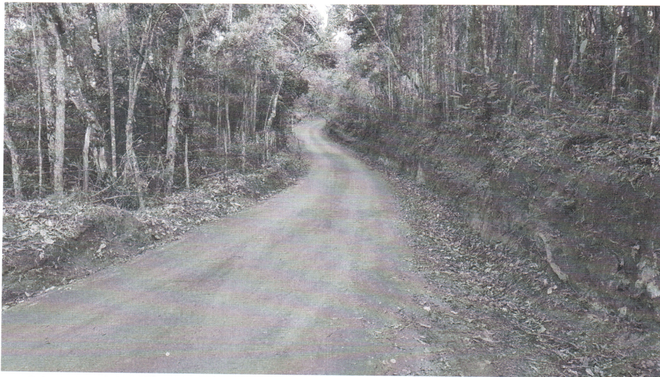
14/10/2024 - Vistoria obra drenagem – Catarina Mendes
