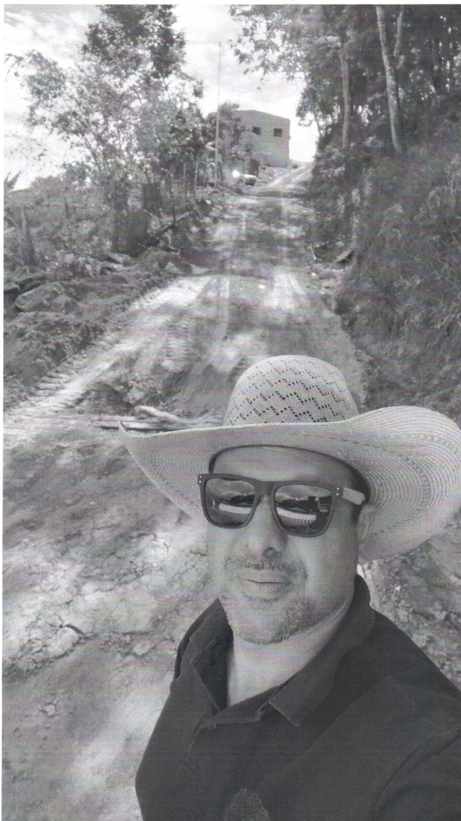
25/10/2024 – Vistoria na obra de drenagem pluvial no distrito de Amarantina.
