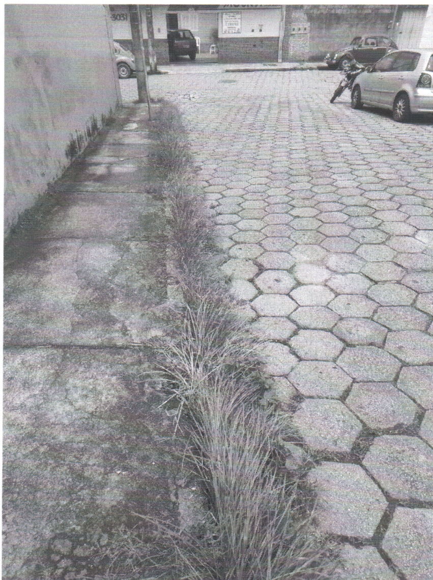
30/10/2024 - Vistoria no bairro Bauxita – Ouro Preto
