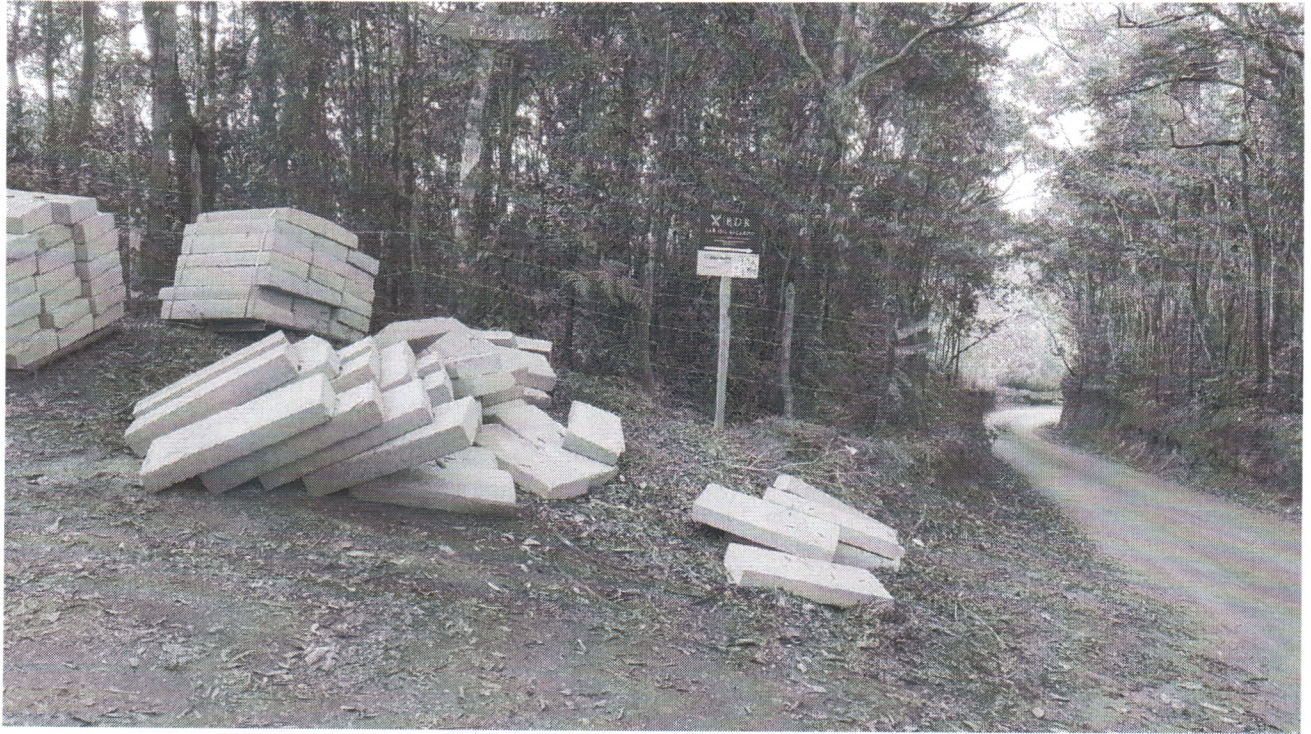
14/10/2024 - Vistoria obra drenagem – Catarina Mendes
