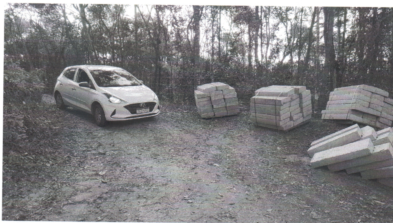
14/10/2024 - Vistoria obra drenagem – Catarina Mendes
