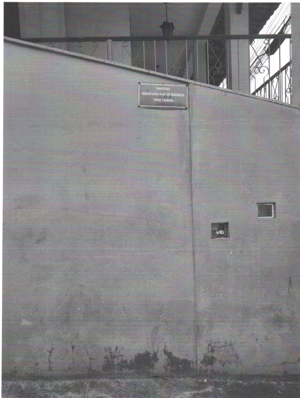
30/10/2024 - Vistoria no bairro Bauxita – Ouro Preto
