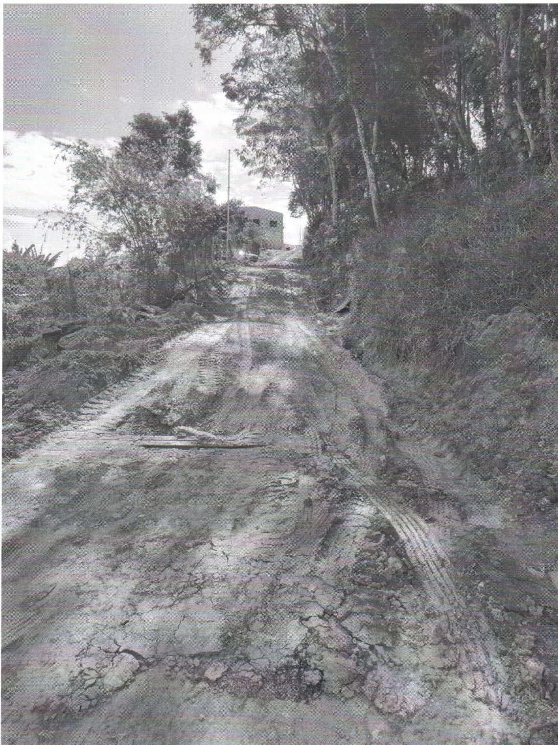
25/10/2024 - Vistoria na obra de drenagem pluvial no distrito de Amarantina.
