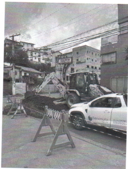
18/12/2024 - Visita ao Bairro Bauxita para fiscalização de serviço executado pela Saneouro na avenida JK.
