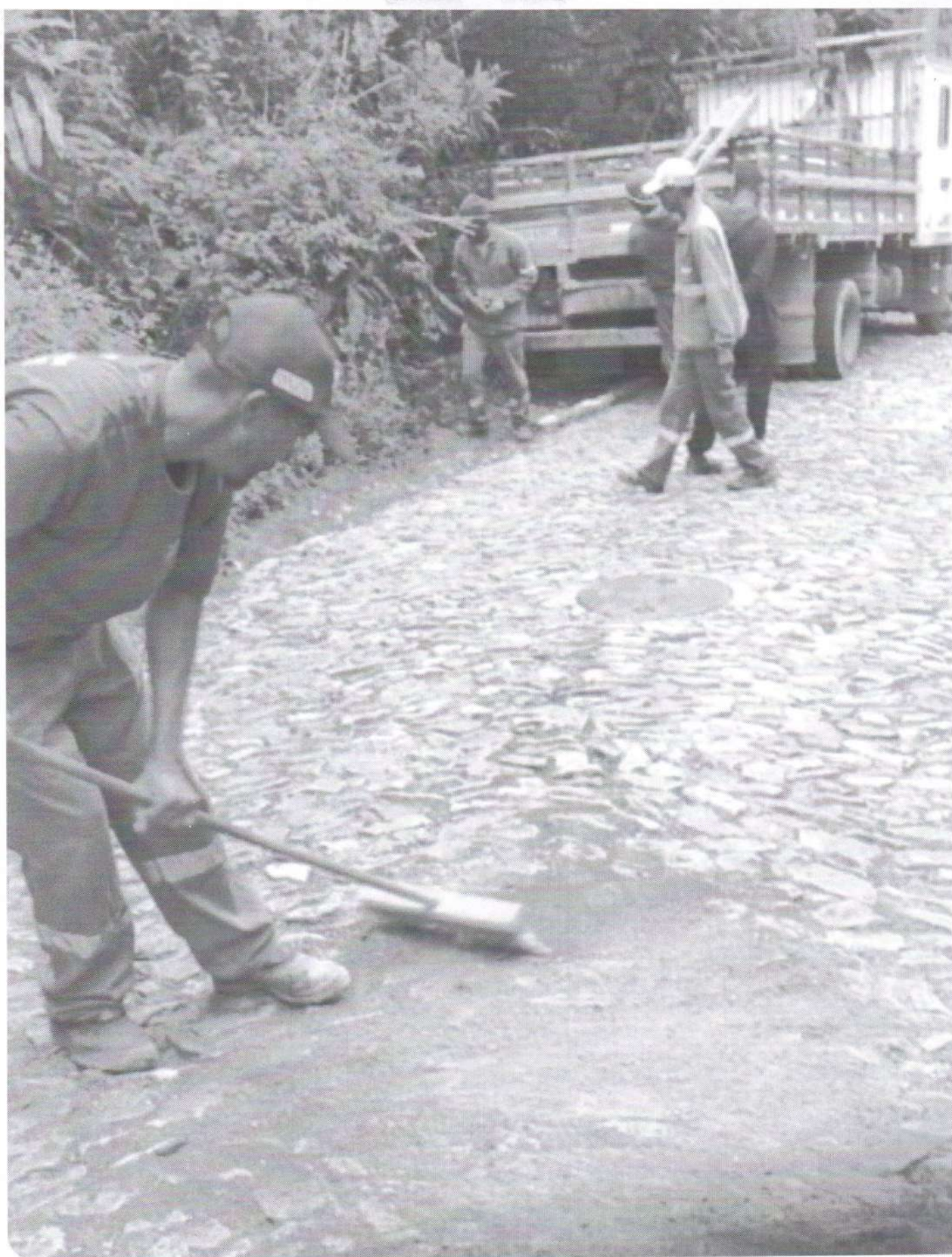
Obras de manutenção do calçamento da rua ladeira João da Deiva
